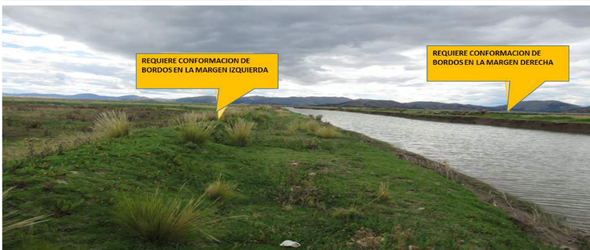
FIGURA N°02: SE PUEDE APRECIAR QUE SE REQUIERE DE REALIZAR PROTECCION DEL ENCIMADO DE BORDE DEL CAUCE DEL RIO TUPIN A LO LARGO DEL TRAMO IDENTIFICADO EN TOTAL UNA LONGITUD DE 5.49 KM.
